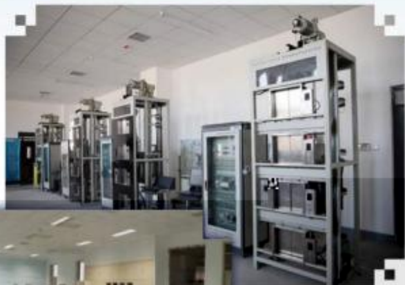
智能电梯安装调试 维护训练场所
